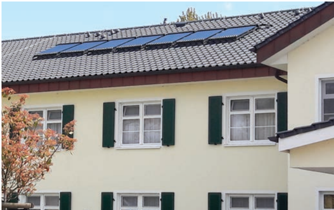
Abb.: Kollektoranlage mit 7 Röhrenkollektoren CC HPV 15
